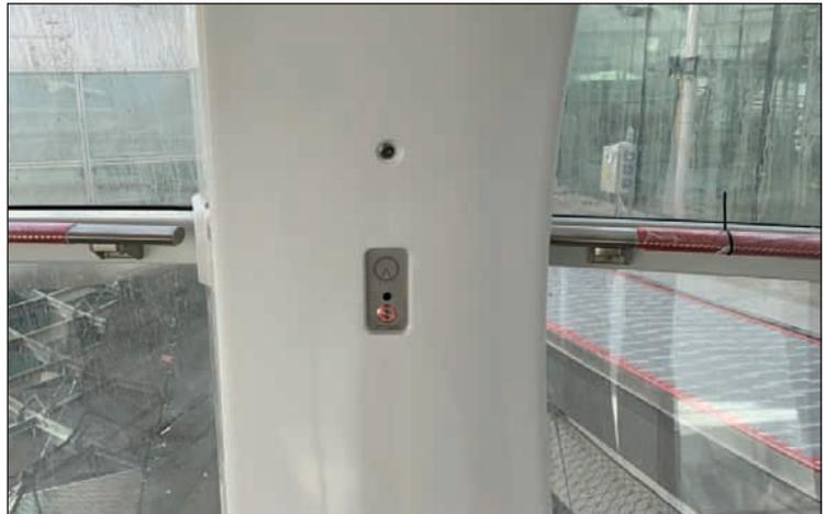
Ogni capsula è stata dotata di un sistema di diffusione audio e comunicazione di emergenza in tecnologia VoIP, safety certified, adattando completamente l'“user interface” alle esigenze del cliente
